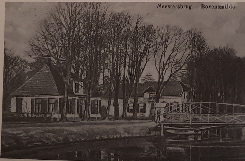
Kanaalweg met Meestersbrug ongeveer 1910.
